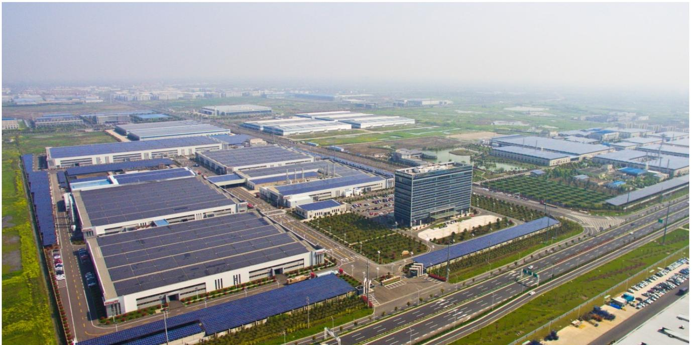
图 1-3 亿晶光电屋顶光伏项目 (3万千瓦)<sup>20</sup>
