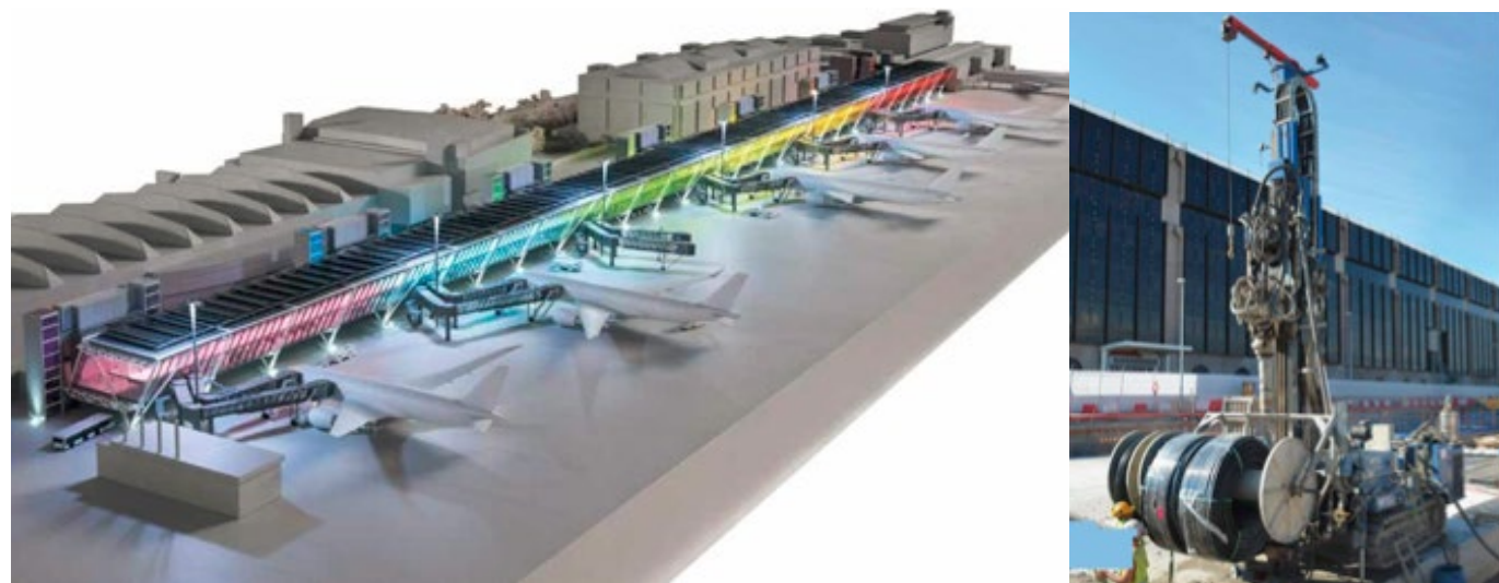
图20: 日内瓦机场东翼楼 — 航站楼的大型地热热泵
