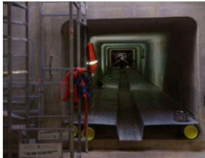
图28：内卡公园的排污明渠热交换器
