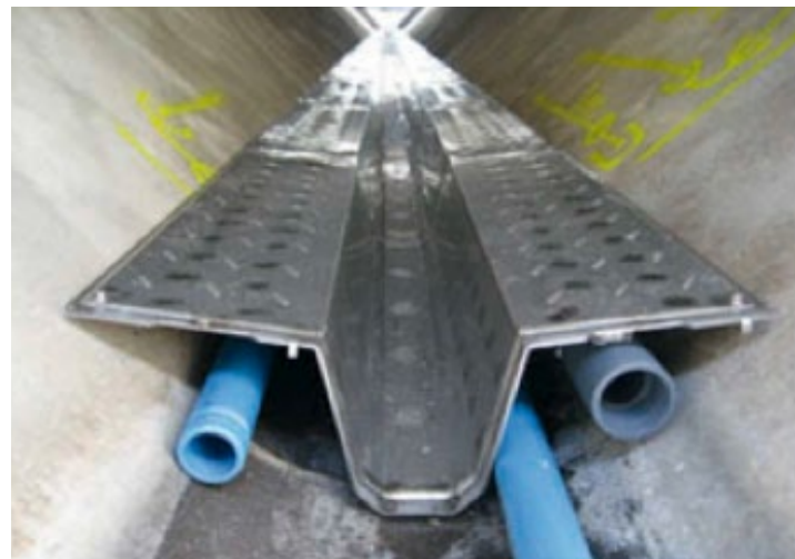
图28：内卡公园的排污明渠热交换器
