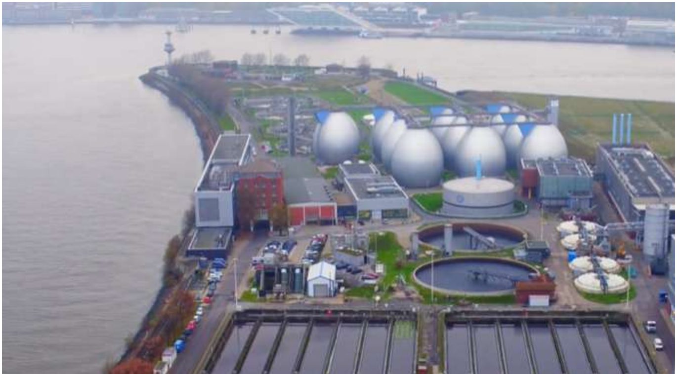
图 9：汉堡水务集团厂区鸟瞰图，背景为发酵罐
