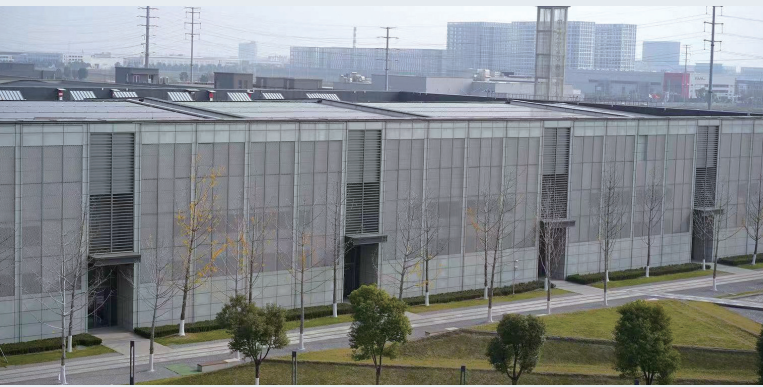
中德中心（常州）办公楼光储充综合解决方案
