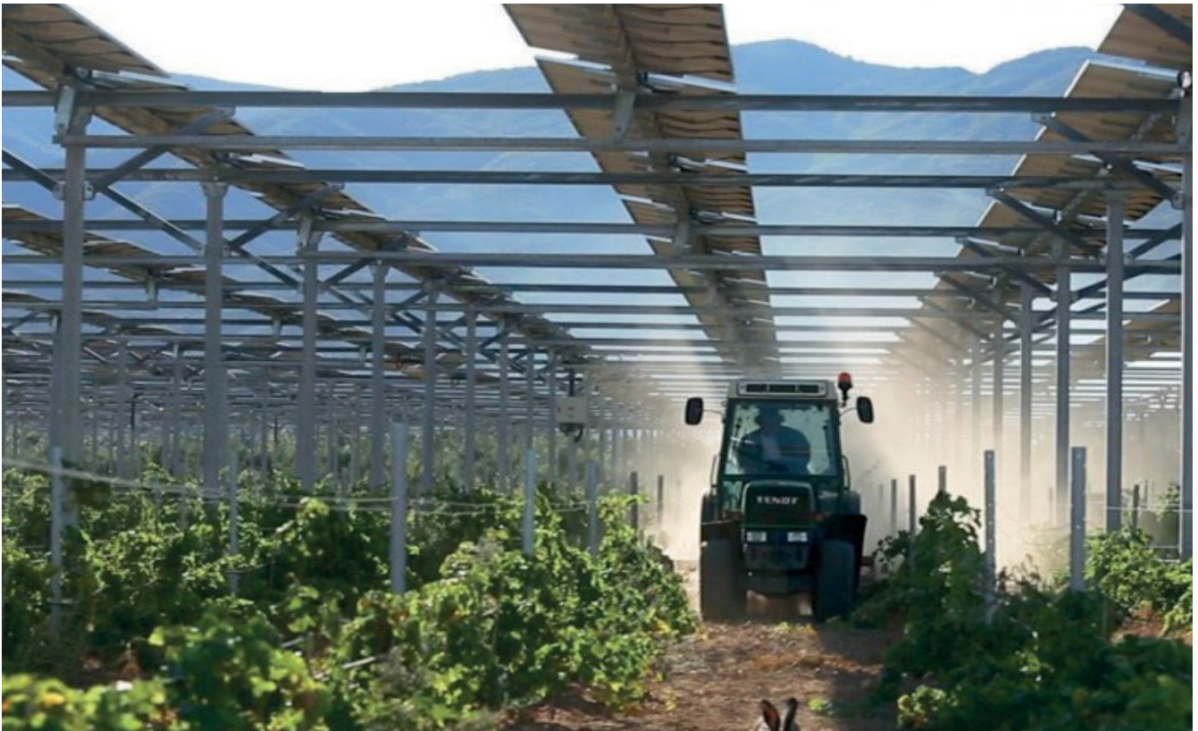
图 44：带有连续组件阵列的农业光伏系统
