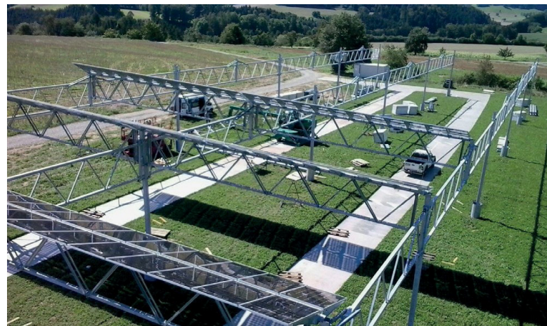
图 53：为避免土壤压实而建的施工道路 © BayWa r.e.
