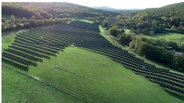
图 51：埃佩尔博恩 - 迪尔明根光伏园区，安装了功率 2MWp 由 Next2Sun 生产的垂直光伏围栏 © Next2Sun GmbH
