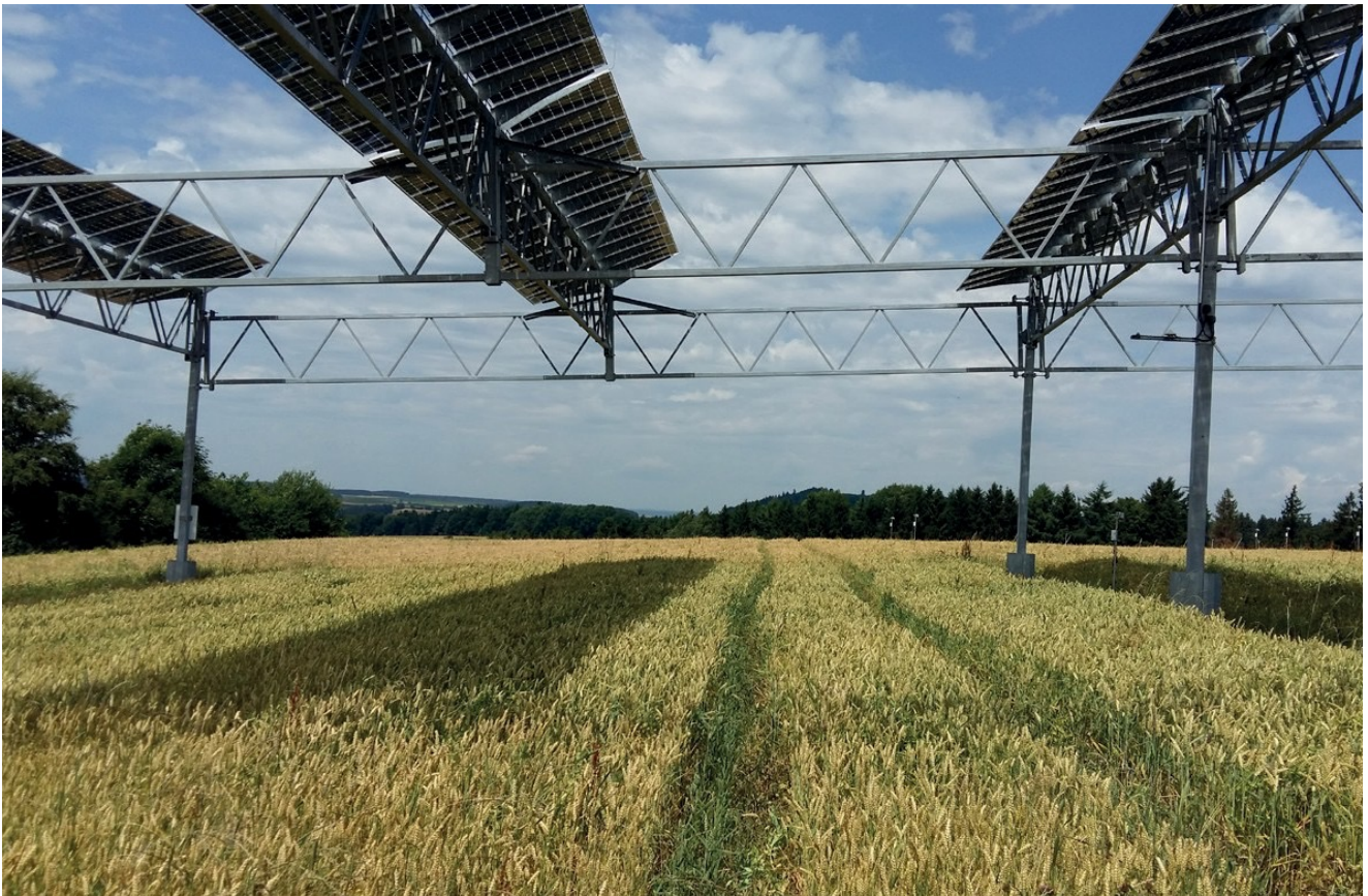
图 48：光伏组件光伏组件的阴影条随太阳高度角移动 © 霍恩海姆大学
