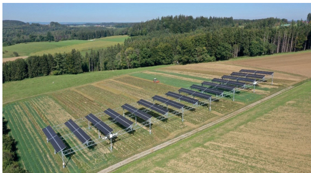
图 50：黑格尔巴赫农业光伏设施，占地面积约三分之一公顷，装机容量为 194 kWp © 弗劳恩霍夫太阳能系统研究所
