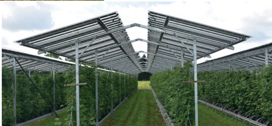
图 38：荷兰的光伏组件扩大了单体太阳能电池间隙且具有保护功能 © BayWa r.e.
