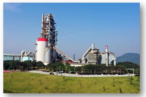
华新水泥在水泥窑大比例替代燃料技术领域取得突破,实现了燃料替代率稳定在60%以上,水泥熟料综合能耗低于50干克标准煤/吨。
